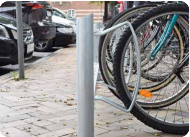
Hjulhållare ska vara utformade för att passa däck i flera olika bredder och tumstorlekar, och hålla cykeln stabilt utan att den tippar åt något håll. (Bild: STELLA)
