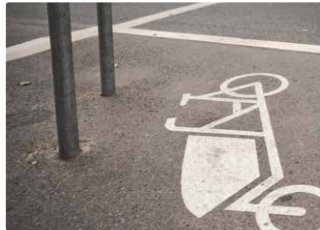
En fördel med cykelbågar är att de kan monteras med extra brett avstånd på platser där de är avsedda att användas av lådcyklar och cykelvagnar.
