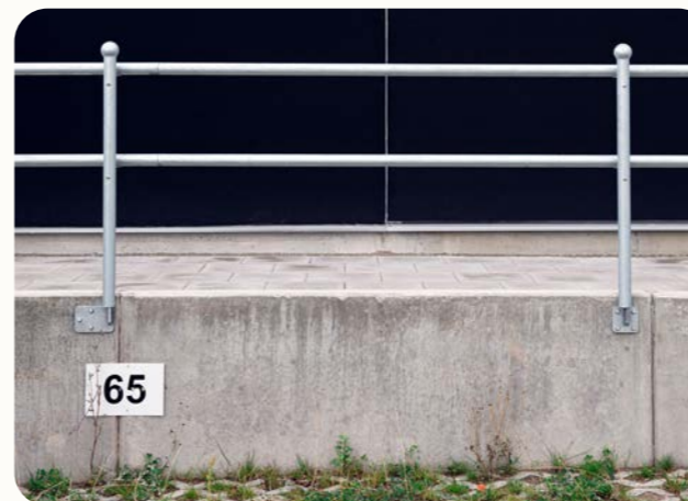
Väggfundament finns i olika varianter för ökad flexibilitet vid montering. I detta exempel undviks montering nära betongblockets kant. (Bild: FLEXI)
