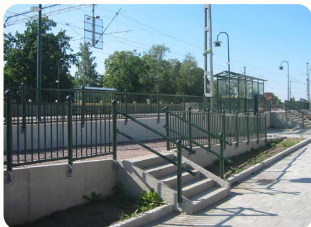
Järnvägsnätet är en högspänningsanläggning och det är viktigt att räcken och andra utrustningar är jordade. (Bild: FLEXI, PRYDNADS spjälmodul)
