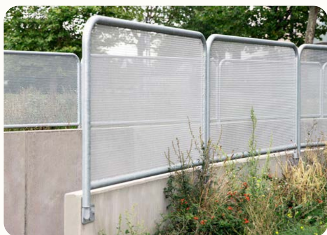
Väggfundament döljs diskret på baksidan av betongmuren sett från förbipasseradesidan. (Bild: STRÄCKMETALLRÄCKE)
