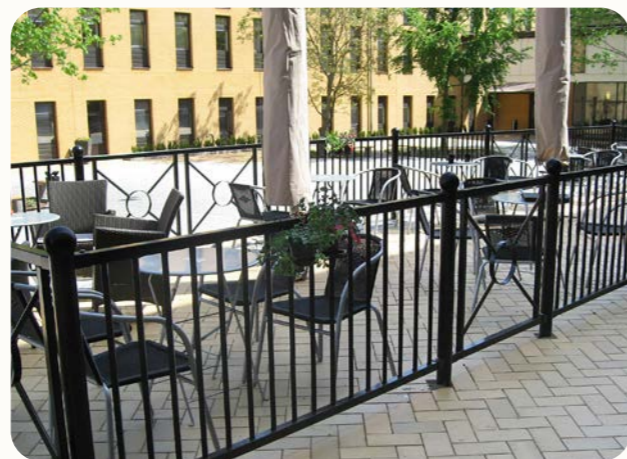
En tvärslå nederst gör att en person med synnedsättning som använder käpp kan upptäcka hindret i tid. (Bild: PRYDNADS spjalmodul, PRYDNADS solmodul)
