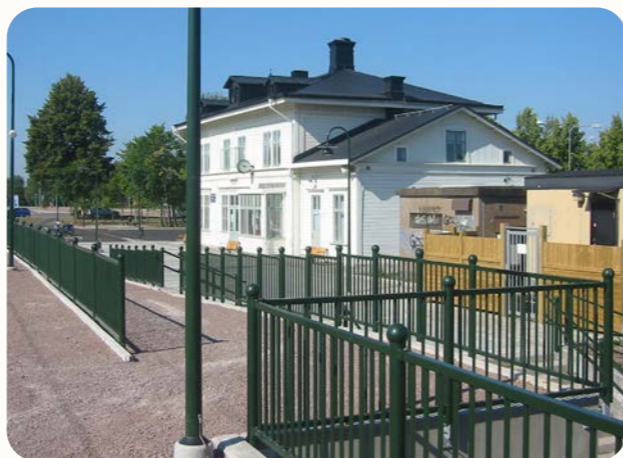
En viktig funktion hos räcken är att styra flödet av passagerare så de förflyttar sig säkert och hittar rätt. (Bild: PRYDNADS spjälmodul).
