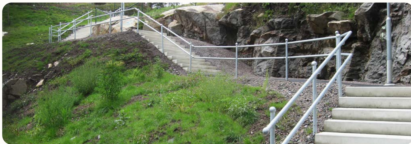
I komplexa miljöer där sluttande gångväg kopplas med trappor, är flexibla och modulära räcken en fördel (Bild: FLEXI)
