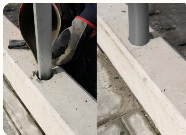
Ingjutningsfundament ger räcket en osynlig infästning, samtidigt som det möjliggör demontering i händelse av en påkörning. (Bild: Ingjutningsfundament Räcke)
