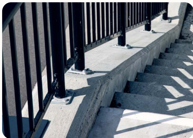
Kombination av standard golvfundament och specialtillverkade vinklade golvfundament för lutande underlag. (Bild: OPTI spjälmodul)
