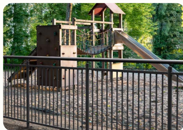
För testning av barnsäkerhet enligt standard SS 13126-5 används ett öppningsmått på maximalt 89 mm. (Bild: OPTI spjalmodul)
