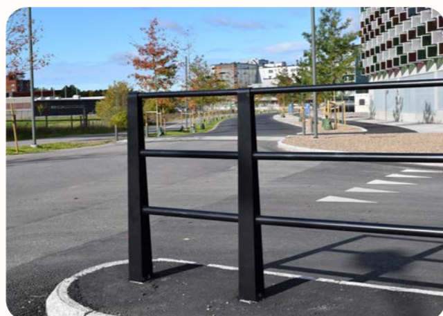
Ingjutningsfundament vid asfalterad yta. (Bild: CITY)
