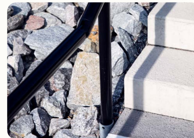
Nedgrävningsfundament i slänt med stenkrossunderlag. (Bild: Nedgrävningsfundament Räckre)
