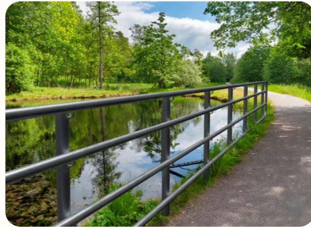
Förhöjt GC-räcke längs djupt vatten > 0,5 m. (Bild: MAXA)
