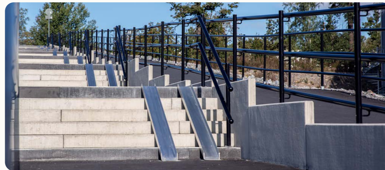
En kombination av olika fundament ger ofta en optimal lösning. Här används golv-, vägg- och nedgrävnings-fundament. (Bild: FLEXI, FLEXI GC)
