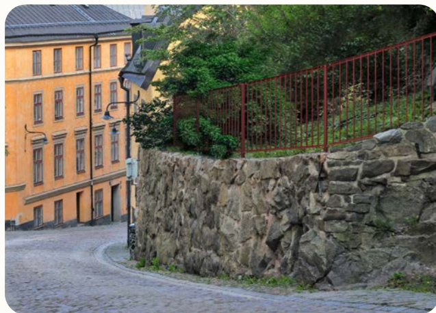
Ett spjälräcke anpassat efter slänten skyddar mot fallolyckor längs tomtens ytterkant. (Bild: LEDAREN)
