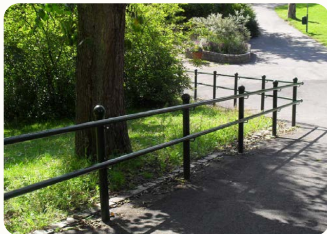
Handledarräcket ger stöd längs den sluttande gångytan samtidigt som det avskärmar parkytan. (Bild: FLEXI)
