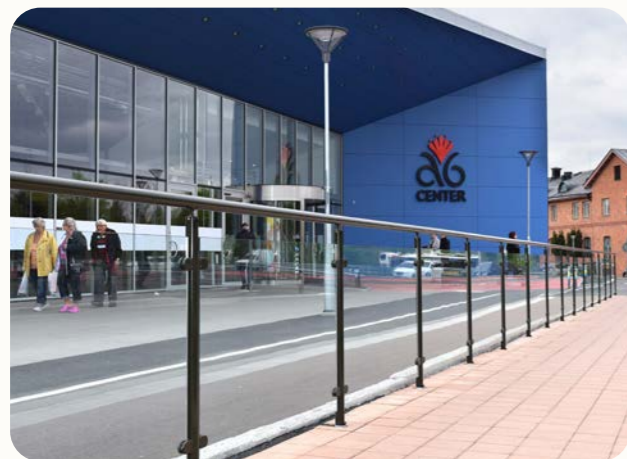
I trafikerade miljöer behövs laminerat säkerhetsglas i glasracket, vilket här har en funktion både som avspärning och stänksydd. (Bild: OPTI glasmodul)
