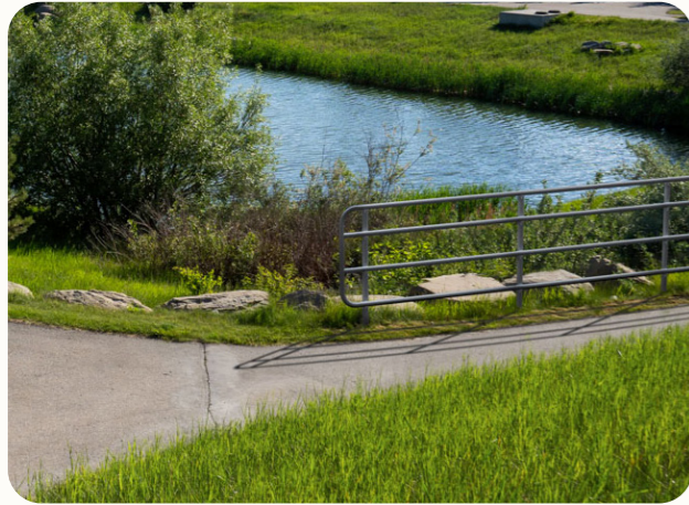
Förhöjt GC-räcke med höjd 1,4 m vid djupt vatten nedanför slänt. (Bild: MAXA)
