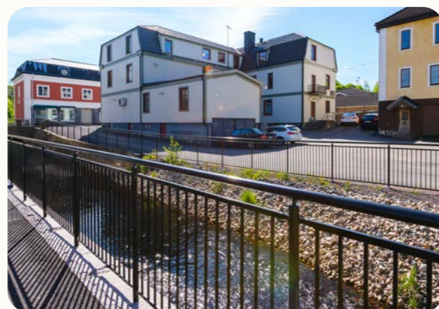
Vertikala spjälor upp till minst 800 mm höjd försvårar för små barn att ta sig över räcket och trilla i vattnet. (Bild: OPTI spjalmodul)
