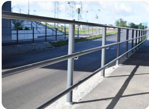
Ett GC-räcke skyddar mot avökning vid höjdskillnader > 0,2 m längs cykelbanans kant. (Bild: FLEXI GC)
