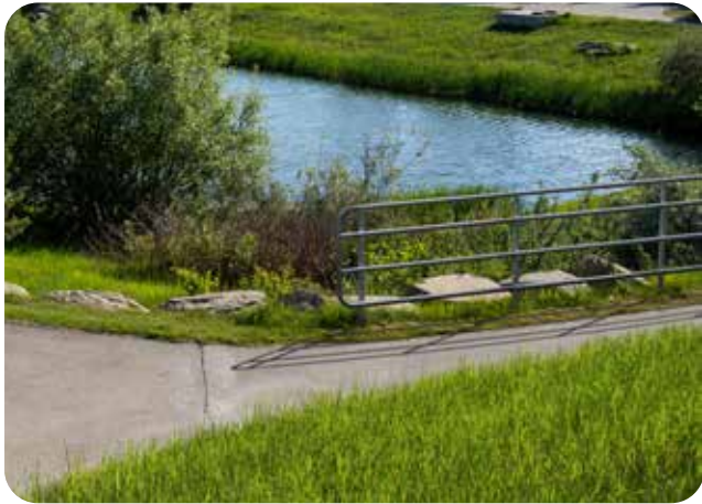
Förhöjt GC-räcke med höjd 1,4 m vid djupt vatten nedanför slänt. (Bild: MAXA)
