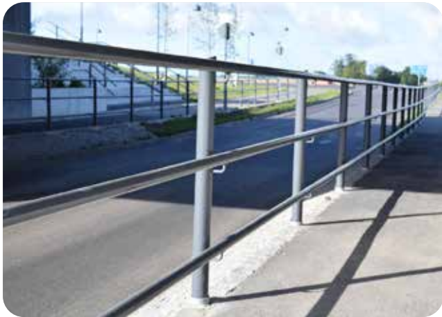
Ett GC-räcke skyddar mot avåkning vid höjdskillnader > 0,2 m längs cykelbanans kant. (Bild: FLEXI GC)
