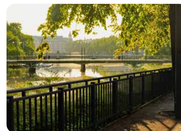
Skydd mot fall längs brant sluttning mot vatten i parkmiljö. (Bild: PRYDNADS spjälmodul överliggare)
