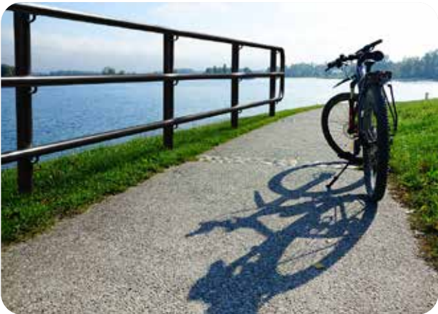
En avslutning på ett GC-räcke utformad för att vara säker för gång- och cykeltrafikanter. (Bild: MAXA)
