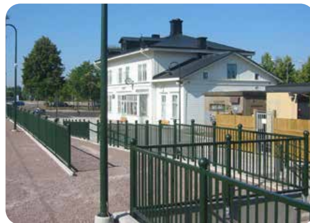
En viktig funktion hos räcken är att styra flödet av passagerare så de förflyttar sig säkert och hittar rätt. (Bild: PRYDNADS spjälmodul).
