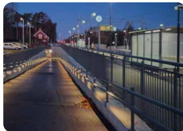
Integrerad räckesbelysning är ett vanligt önskemål i områden kring resecentrum, där människor rör sig under de flesta av dygnets timmar. (Bild: FLEXI, OPTI spjälmodul)
