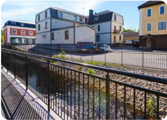
Vertikala spjälor upp till minst 800 mm höjd försvårar för små barn att ta sig över räcket och trilla i vattnet. (Bild: OPTI spjälmodul)
