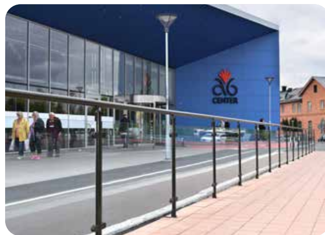
I trafikerade miljöer behövs laminerat säkerhetsglas i glasträcket, vilket här har en funktion både som avspärning och stängskydd. (Bild: OPTI glasmodul)
