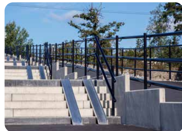
En kombination av olika fundament ger ofta en optimal lösning. Här används golv-, vägg- och nedgrävningsfundament. (Bild: FLEXI, FLEXI GC)
