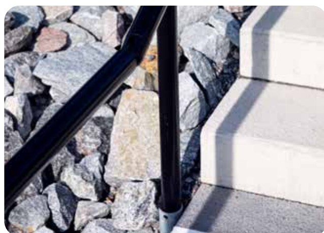
Nedgrävningsfundament i slänt med stenkrossunderlag. (Bild: Nedgrävningsfundament Räcke)
