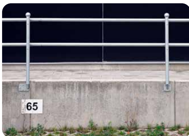
Väggfundament finns i olika varianter för ökad flexibilitet vid montering. I detta exempel undviks montering nära betongblockets kant. (Bild: FLEXI)
