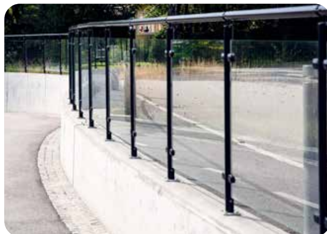
Golfundament är en av de vanligaste förankringslösningarna och är lätt att montera i befintliga miljöer. (Bild: OPTI glasmodul)
