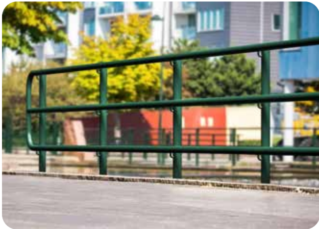
Ett GC-räckes vertikala delar har ett internt avstånd på maximalt 0,45 m för att förhindra fall genom räcket. (Bild: MAXA)
