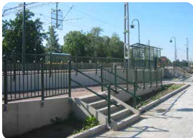
Järnvägsnätet är en högspänningsanläggning och det är viktigt att räcken och andra utrustningar är jordade. (Bild: FLEXI, PRYDNADS spjälmodul)
