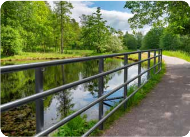
Förhöjt GC-räcke längs djupt vatten > 0,5 m. (Bild: MAXA)
