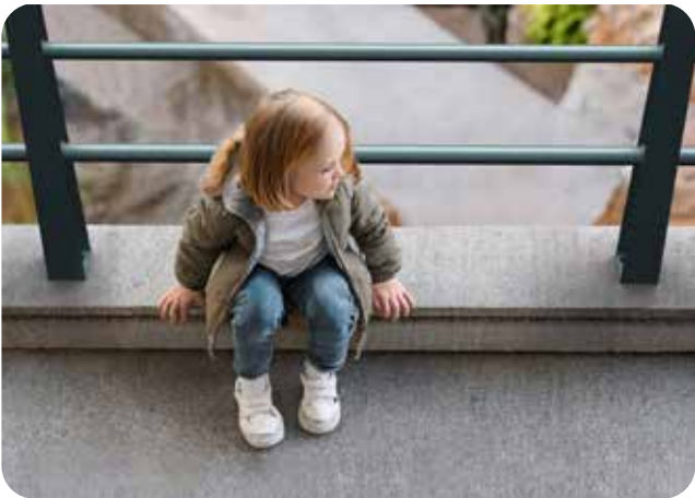
Ett litet barns proportioner, med stort huvud i förhållande till kropp, gör att det bli hängande i huvudet i öppningar på 110–230 mm. (Bild: CITY)
