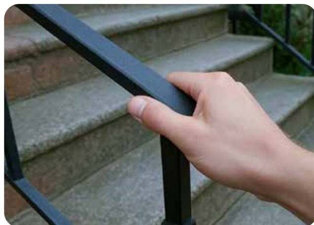
En platt ledstång är dåligt utformad eftersom den inte är lätt att greppa om.
