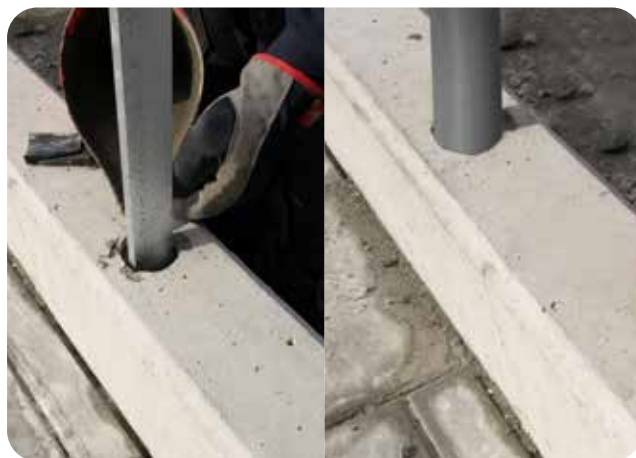
Ingjutningsfundament ger räcket en osynlig infästning, samtidigt som det möjliggör demontering i händelse av en påkörning. (Bild: Ingjutningsfundament Räcke)
