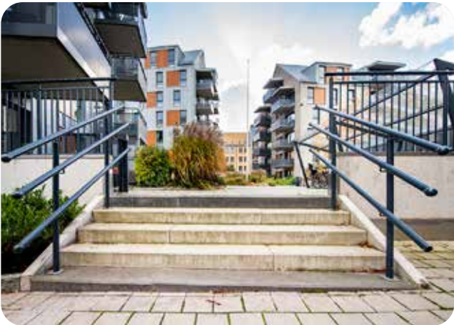
Trappor och ramper på en tomt ska ha balansstöd i form av ledstång, om det behövs för att skydda mot fall. (Bild: OPTI, OPTI spjälmodul)
