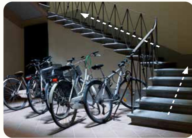
Vid förvaring i källarutrymmen som nås med trappor underlättar en styrskena i metall, monterad ca 30 cm från väggen. (Placering vid höger sida, sett nerifrån, föredras oftast.)
